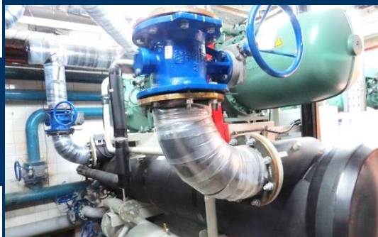
پس از بازسازی
