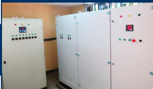
پس از بازسازی
